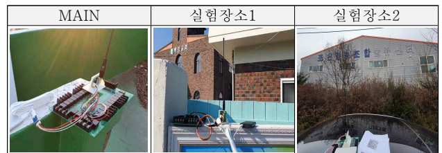
[표 2] 통신거리 테스트 현장 사진
