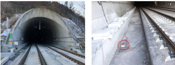
[그림 1] 대상 터널 전경 및 설치된 온도계
