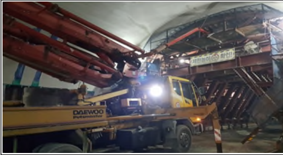
[그림 5] 콘크리트 펌프차 활용 현장타설 콘크리트 라이닝 작업
