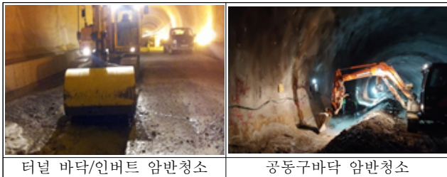
[그림 2] 터널바닥 암반청소 실태(터널바닥/공동구바닥)
