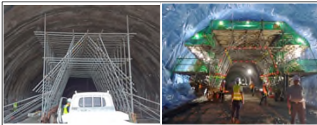
[그림 6] 터널 내 방수 작업용 대차 조립 및 해체
