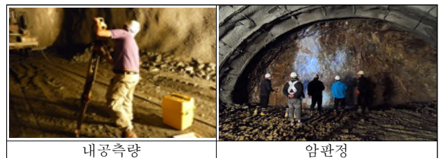
[그림 1] 터널 내공측량 및 암반정
