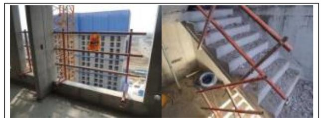
[그림 2] 안전난간대/계단난간대
