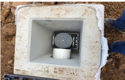
(h) 필터부 설치
