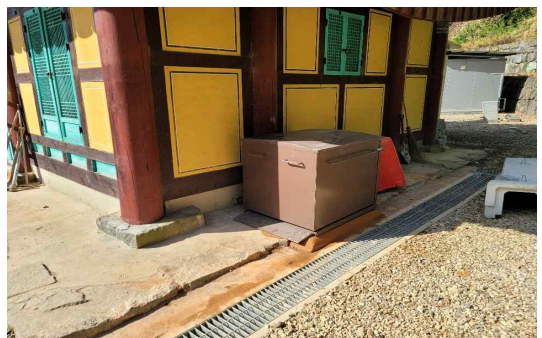
(m) 이동식 소화펌프 설치
