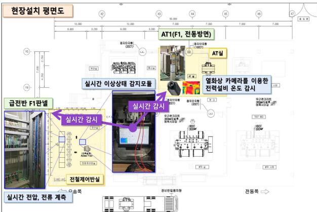
[그림 270] 실시간 전력감시시스템 현장설치
