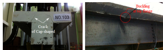
(d) Cracks of end section
