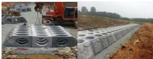
Fig. 1. Site test construction
