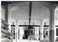
Fig. 9. Warehouse in Zurich 1910, Robert Maillart
