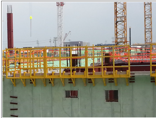
Fig. 7. MDW concrete pouring
