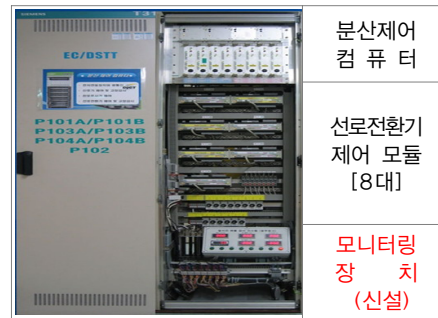
[그림 11] 모니터링장치 설치
