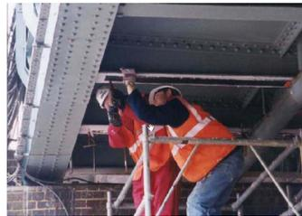
[그림 1] 런던 Action Bridge의 보강사진
