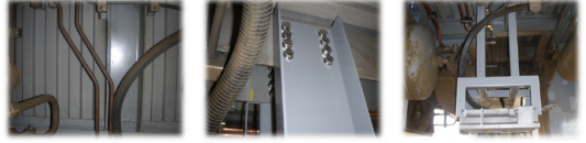
4-1) CAU 브라켓 설치 위치
