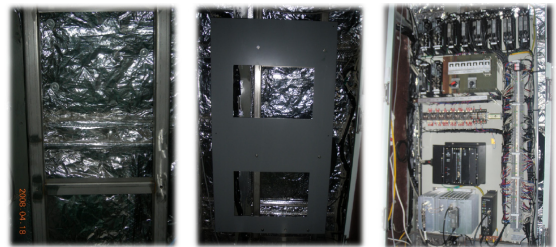
1) 설치 전 ATP MOUNTING FRAME 2) ATP BOARD 고장 BRACKET 설치 3) ATP BOARD 설치 완료
