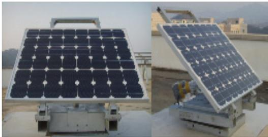
[그림 3] 태양광 추적식 발전 시스템
