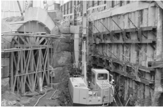
[그림 6] 현장 심층혼합처리 시공 사진
