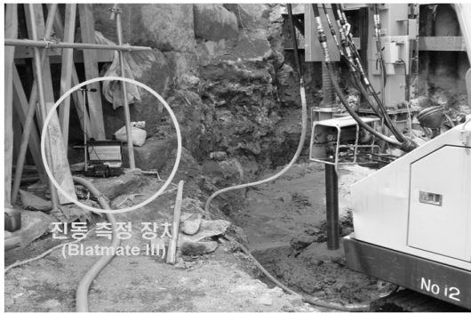
[그림 8] 심층혼합처리 시공 중 진동측정
