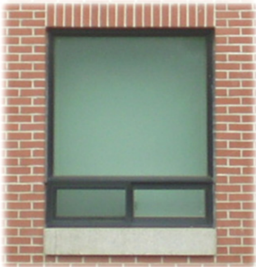
[그림 2] 평가대상 슬라이딩 타입 알루미늄 합금 창호 적용 현황 [Fig. 2] Shape of Sliding Type Aluminum Alloy Window
