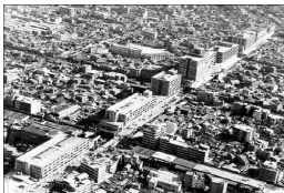
[그림 33] 세운상가 전경 [Fig. 33] Seun Complex
