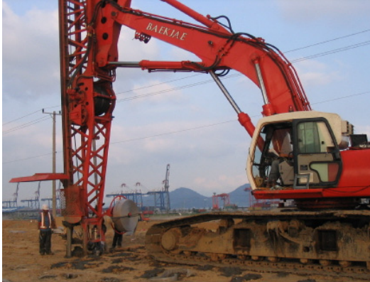
[그림 9] 개발 장비로 측정 중인 시공 모습
