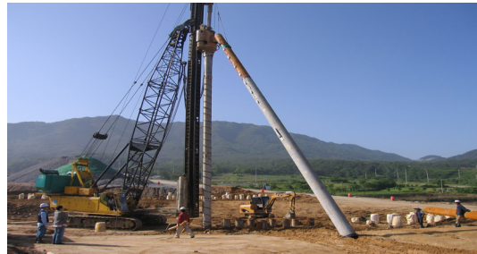
[그림 3] 계측기가 설치된 복합말뚝 관입 전경 [Fig. 3] Pile installation
