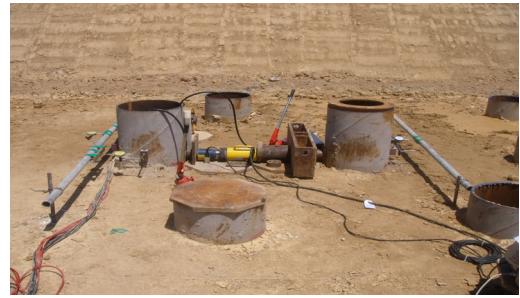
[그림 2] 말뚝 수평 재하 시험 전경 [Fig. 2] Lateral loading test on the pile
