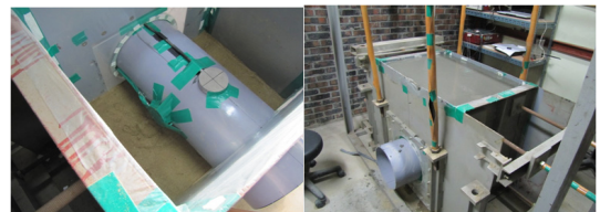
(3) 관 및 계측기 설치
