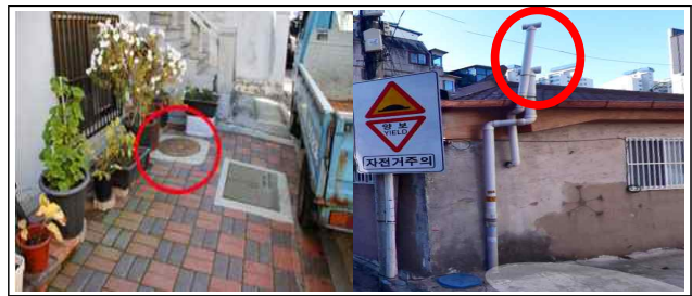
[그림 5] 저층 주택단지 정화조 틈새 및 환기구 노출 실태
