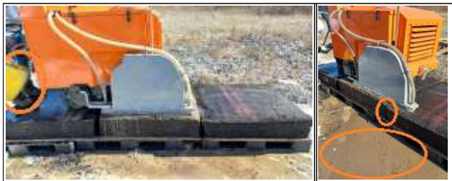
[그림 3] 절단슬러지 회수 [그림 4] 절단슬러지의 누수
