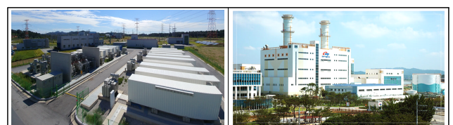
[그림 6] 고창 ESS(좌) 및 군산복합화력발전소(우)
