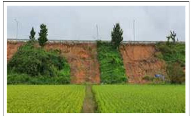
[그림 3] 표층유실로 인한 사면 붕괴 예시
