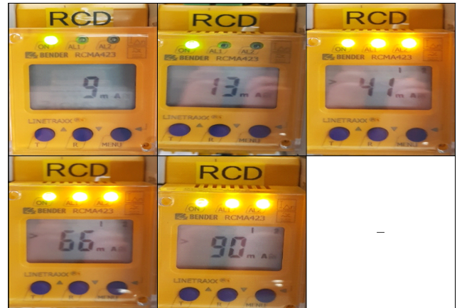
[그림 4] RDC를 이용한 누설전류 측정
