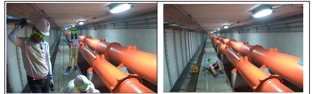
[그림 1] Yolo v7 pose 적용결과: 다중 객체(좌)와 쓰러짐(우)
