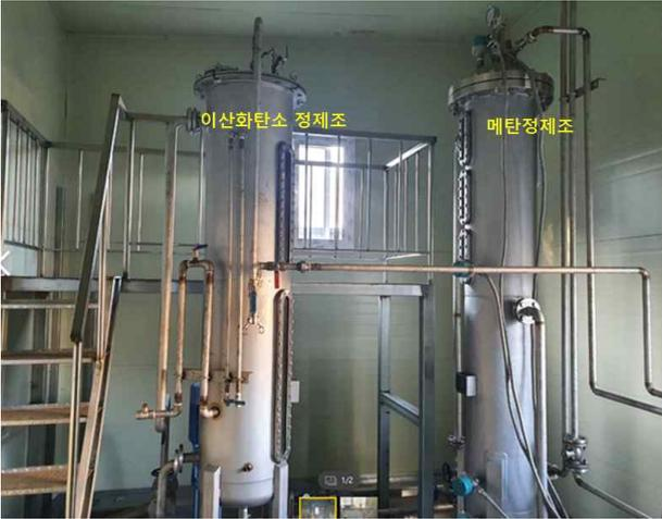
[그림 1] 바이오가스 습식정제 Pilot Plant
