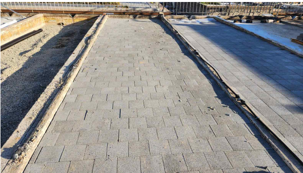
[그림 4] 저류형 투수블록의 시공
