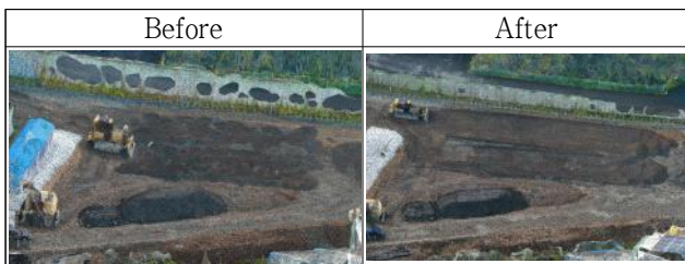
[그림 1] 재래식 시공과 머신컨트롤 시공 전후 사진
